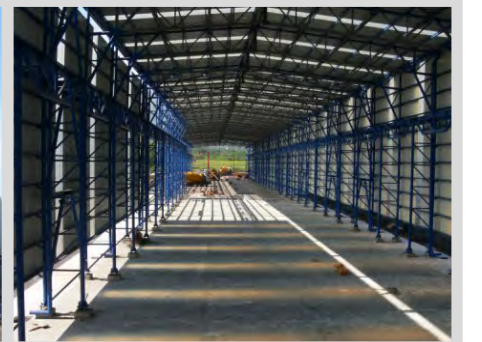
İç görünüş Interior view
