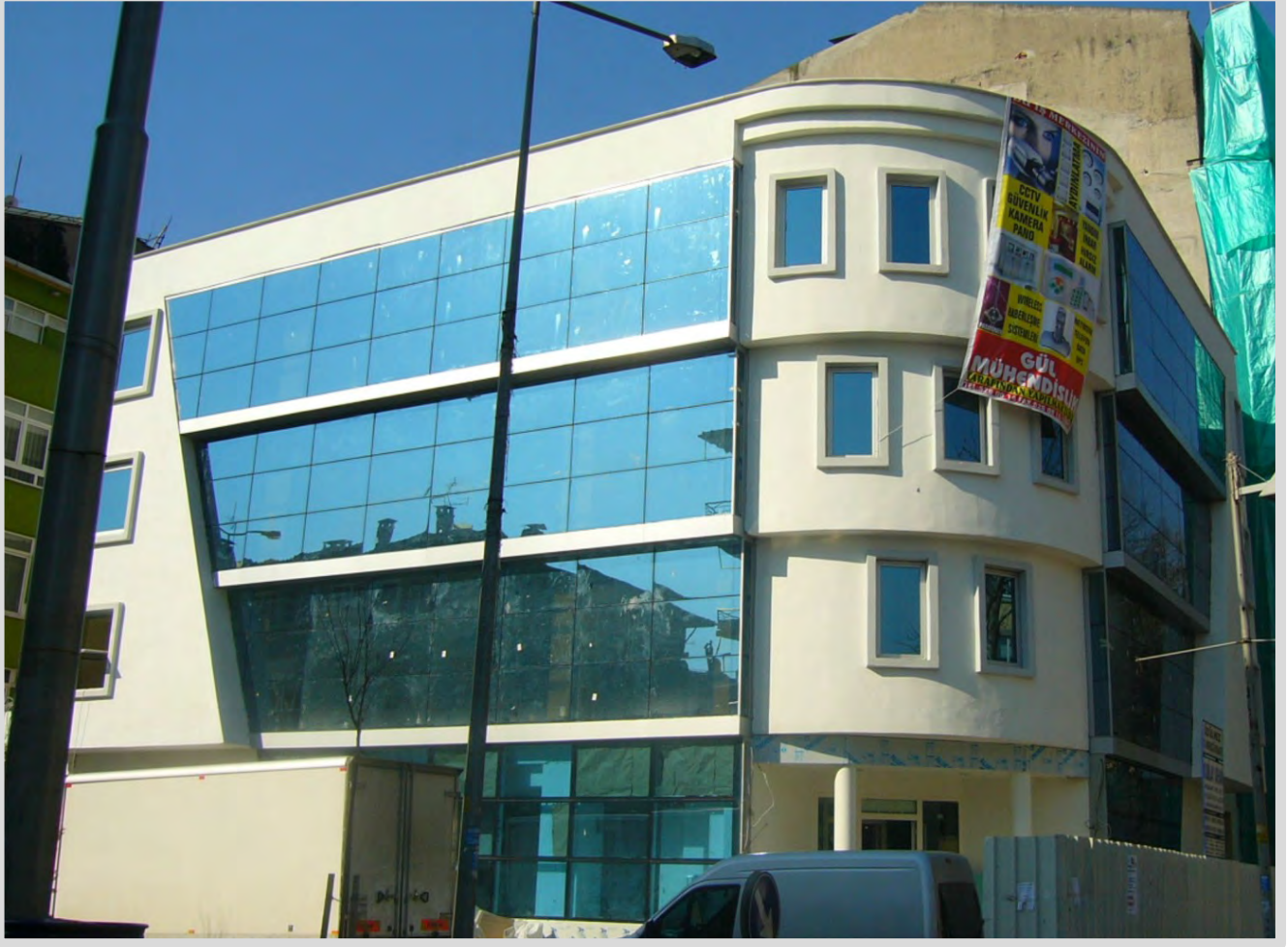
İbrahim ÜZÜLMEZ iş merkezi inşaatı
