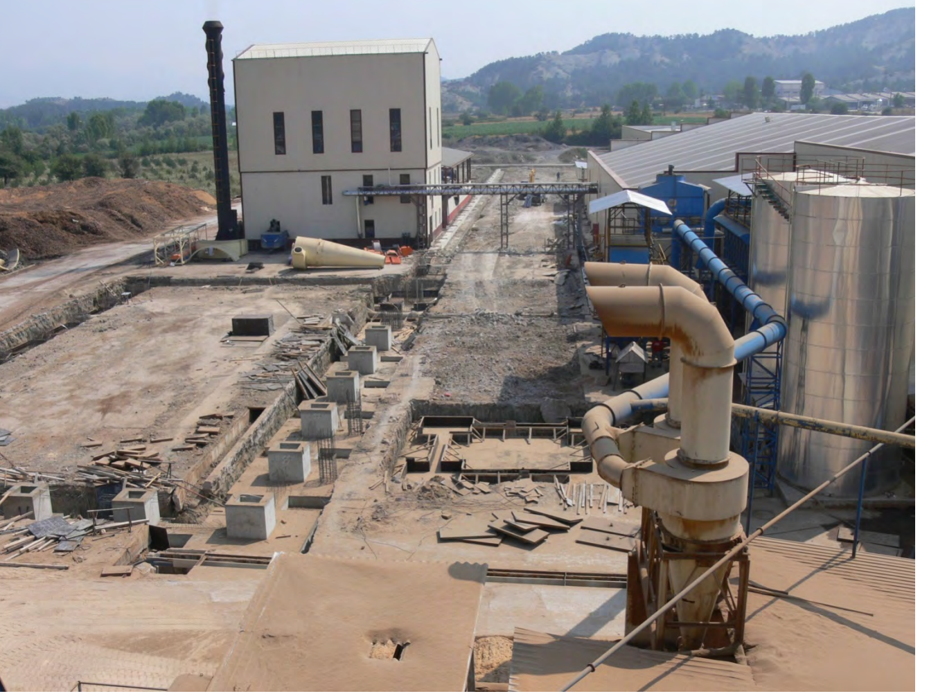
MAKİNE TEMELLERİ VE PRESS HATTI İNŞAATI
